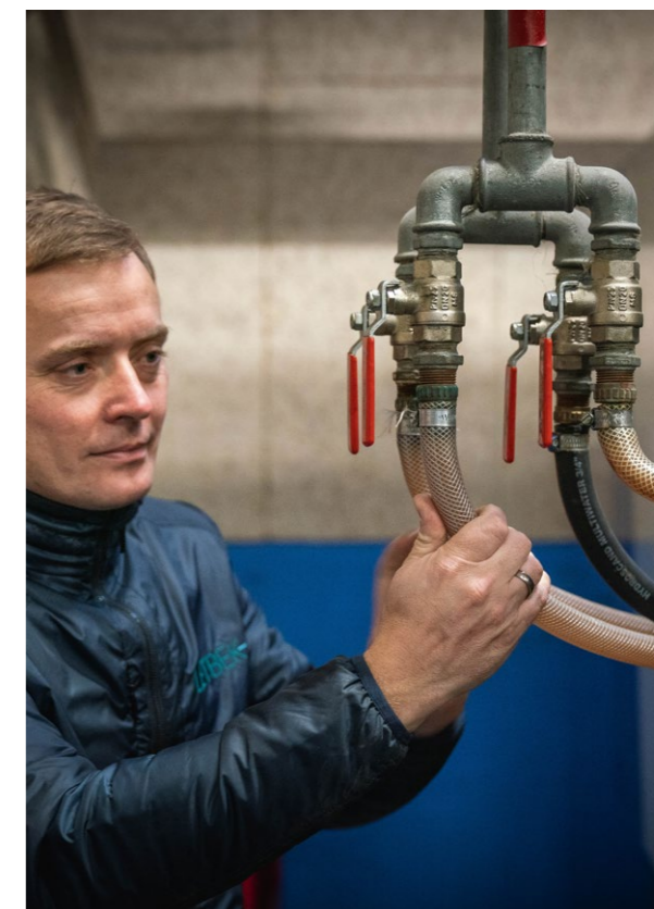
▲ Slangerne har nu den rigtige længde for at undgå tryktab, og medarbejderne er blevet bedre til at opdage og melde lækager ind.
