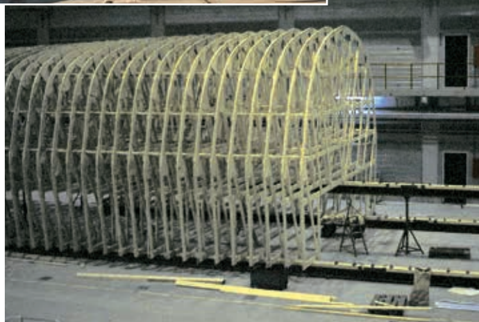
Spantekonstruktion til Standard Flex 300 under opbygning
