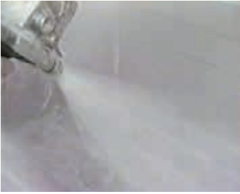
Sprøjteoplægning (Reichhold A/S/Aplicator System AB)
