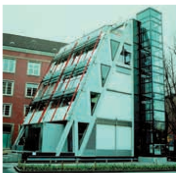
Eyecatcher-bygningen med bærende konstruktion i glasfiberforstærket plast (Fiberline Composites A/S)
