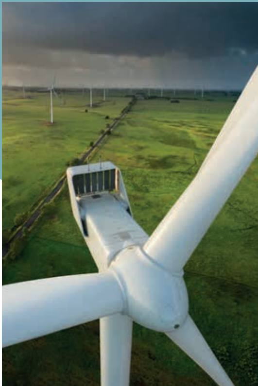
Vindmølledele i hærdeplast (Vestas Wind Systems A/S)
